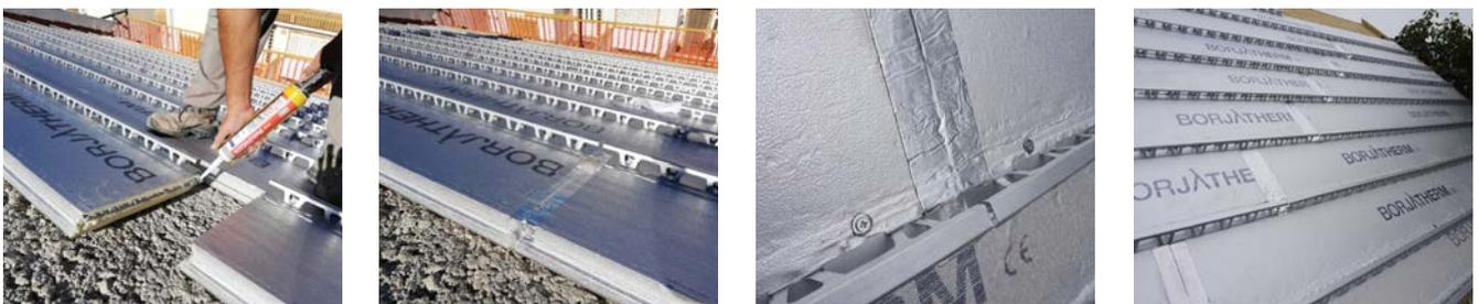
Si la pendiente de la cubierta está por debajo del 30% (17°) se colocará una lámina impermeable entre el soporte y el panel de aislamiento para mayor estanqueidad. Además, se recomienda en tejados con bajas pendientes sellar también las juntas longitudinales entre paneles con un cordón continuo de masilla PU sobre el escalón del machihembrado.
