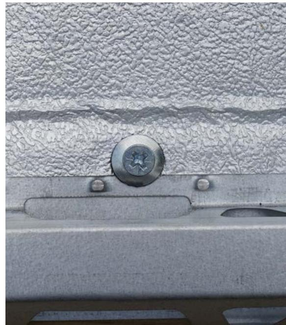
Cuando la fijación se realice sobre forjado de hormigón se realizará un taladro previo. Sobre esta perforación se recomienda insertar unas gotas de masilla de poliuretano previo a la colocación y fijación del taco.
