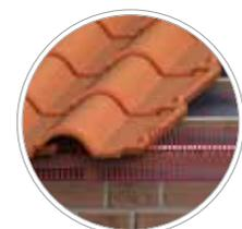
Las tejas mixtas se instalan de izquierda a derecha y desde el alero a la cumbrera. El vuelo de la primera hilada de tejas será variable, dependiendo del modelo y de la instalación.
