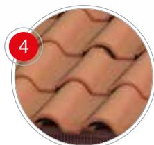
Las tejas de ventilación se instalan de la misma forma que el resto de tejas, encajándose lateral y superiormente. Se repartirán por los faldones en función de la superficie.
