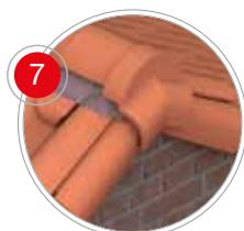
Sobre el rastrel de cumbrera se colocará el Bajo-Cumbrera, fijándolo con grapas o clavos. Los rollos disponen de bandas de adhesivo butílico para fijarse sobre el perfil de las tejas e impermeabilizar la unión.
