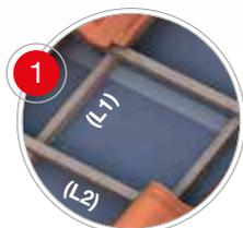
Sobre el soporte de la cubierta se deberá colocar una membrana impermeable transpirable y, a continuación, se instalarán los rastres principales cada 50/70 cm, paralelos a la línea de máxima pendiente (L1). Sobre los primarios se fijarán los rastres horizontales de apoyo para las tejas (L2), según la longitud útil de cada modelo de teja (se deberá comprobar en obra según UNE - 136020).
