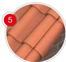
Los remates laterales (izquierdos y derechos) se instalarán siguiendo el paso de la teja, quedando los laterales por debajo de la teja. Para finalizar el faldón en el lado derecho se rematará sobre el lateral con la media teja o la teja y media, dependiendo de la anchura del faldón.
