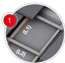
Sobre el soporte de la cubierta se deberá colocar una membrana impermeable transpirable y, a continuación, se instalarán los rastroles principales cada 50/70 cm, paralelos a la línea de máxima pendiente (L1). Sobre los principales se fijarán los rastroles horizontales de apoyo para las tejas (L2), según la longitud útil de cada modelo de teja.
