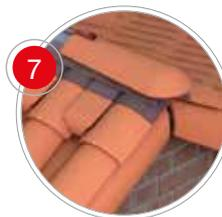
On placera le cloisir sur le liteau de faîtage, en le fixant à l'aide d'agrafes ou de clous. Ces rouleaux sont équipés d'une bande adhésive en butyle pour adhérer parfaitement aux tuiles et assurer l'étanchéité de la jonction.
