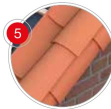
L'installation des rives s'effectuera de telle sorte que celles-ci se situent sous les tuiles de couvert formant les flancs et suivent le passage de la tuile canal.
