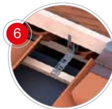
Le liteau de la ligne de faîtage devra être fixé sur les supports de liteau. Cette fixation au support s'effectuera selon la pente et la hauteur nécessaires, de sorte que les tuiles de faîtage soient directement soutenues par les tuiles de la dernière rangée et par les sous-faîtières.
