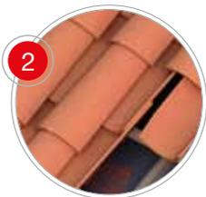
Pour procéder à la pose à sec des tuiles de couvert, on utilisera les crochets pour tuile canal afin de maintenir un pureau constant sur toutes les rangées du rampant. Pour les pentes prononcées, nous recommandons de renforcer la jonction à l'aide d'une mousse PU spécifique pour la fixation des tuiles.
