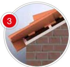
On débutera la pose par la première rangée de tuiles et l'on maintiendra une distance constante entre les axes, en laissant une séparation de 3-7 cm pour le passage de l'eau. La saillie des tuiles sera supérieure à 5 cm. Le recouvrement des tuiles sera déterminé par la région et de la pente.
