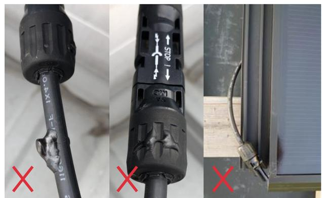
Pour prévenir la dégradation des câbles, évitez au maximum de les exposer directement à la lumière du soleil ou de les tacher avec un produit destiné utilisé pour l'installation de la toiture, quel qu'il soit (mousse, adhésif, mortier, asphalte,...).
