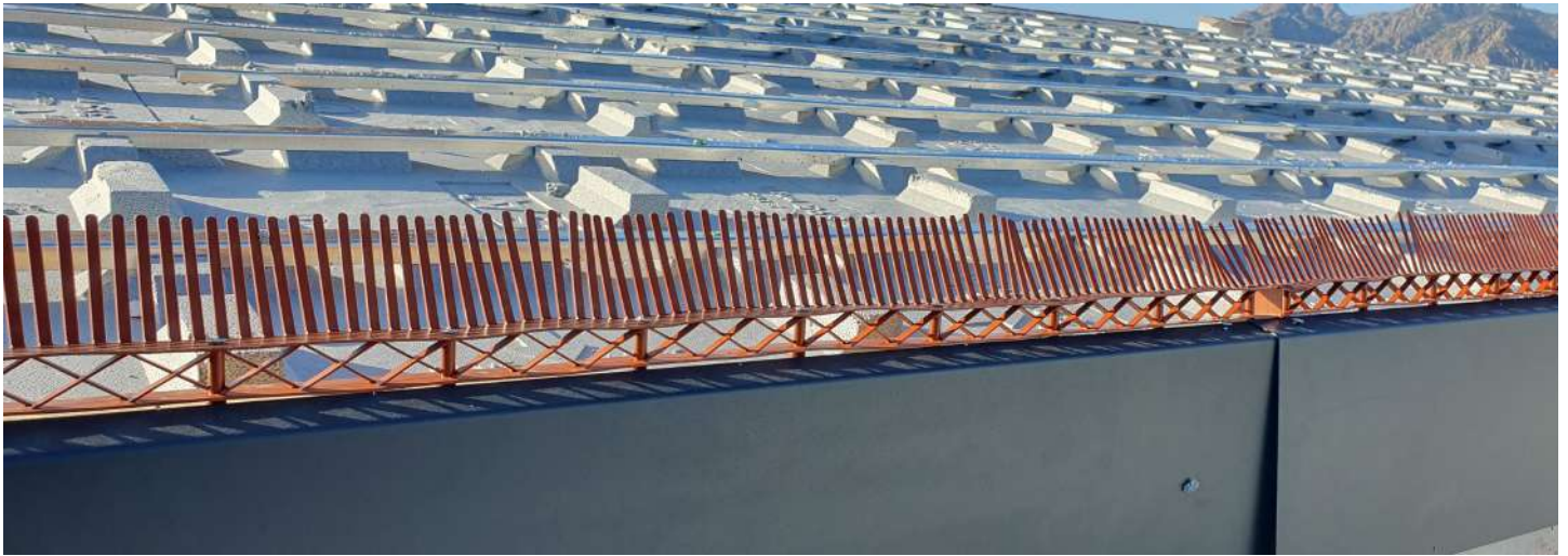
Rastrel + Peine Alero rojo Panel SAT y Rastrel metálico U 40 x 15
