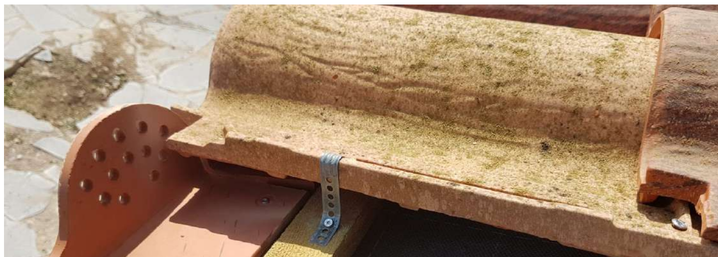
Gancho/Clip Alero tejas con encaje
