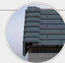
Les finitions latérales (gauches et droites) s'installeront en chevauchant les tuiles et en suivant le passage des tuiles. Pour terminer le rampant du côté gauche, on s'arrêtera au-dessus de la tuile ou de la Demi-tuile, en fonction de la largeur du rampant et de la technique de pose (en ligne ou quinconce).
