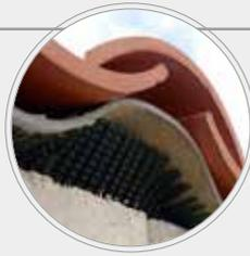
Se instalan empezando por la primera hilada de tejas, asegurando una distancia entre ejes constante, dejando una separación libre de paso de agua de 3-7 cm. El vuelo de las tejas será superior a 5 cm. El solape de las tejas será determinado según zona y pendiente.
