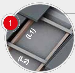
Sobre el soporte de la cubierta se deberá colocar una membrana impermeable transpirable y, a continuación, se instalarán los rastreles principales cada 50/70 cm, paralelos a la línea de máxima pendiente (L1). Sobre los principales se fijarán los rastreles horizontales de apoyo para las tejas (L2), según la longitud útil de cada modelo de teja (se deberá comprobar en obra según UNE - 136020).
