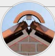
Sobre el rastrel de cumbre se colocará el Bajo-Cumbre (Mixto, Aluminio o Rígido), fijándolo con grapas o clavos. Los rollos disponen de bandas de adhesivo butílico para fijarse sobre el perfil de las tejas e impermeabilizar la unión.
