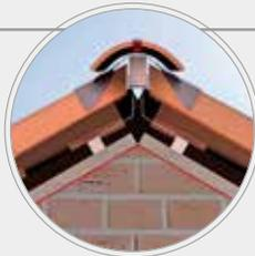
Sobre el rastrer de cumbre se colocará el Bajo-Cumbre (Mixto, Aluminio o Rígido), fijándolo con grapas o clavos. Los rollos disponen de bandas de adhesivo butílico para fijarse sobre el perfil de las tejas e impermeabilizar la unión.
