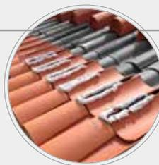
Estructura con placa bajo teja. Seguir las normas de instalación en vigor para placas bajo teja.
