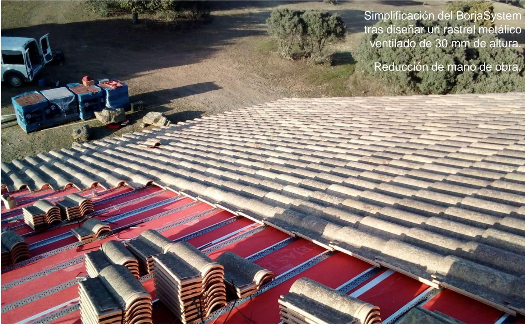
Simplificación del BorjaSystem tras diseñar un rastrel metálico ventilado de 30 mm de altura.
