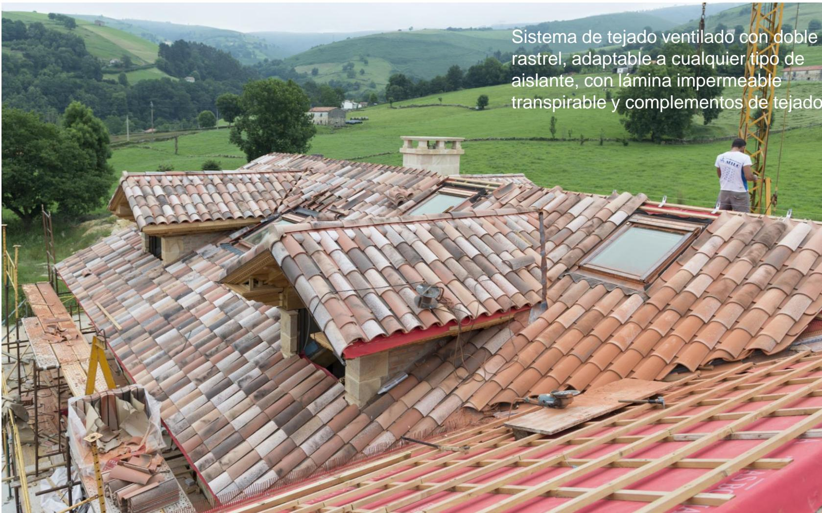
Sistema de tejado ventilado con doble rastrel, adaptable a cualquier tipo de aislante, con lámina impermeable transpirable y complementos de tejado.
