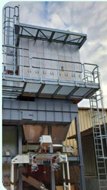
En el primer trimestre de 2024, la planta de Phalempin invirtió en un depurador de nueva generación para la limpieza de los humos del horno. Gracias a una depuración mejorada, el calor residual de estos humos se puede recuperar ahora para el secado de las tejas, compensando así el elevado consumo de gas del secador. En total, significa un ahorro anual de 900 toneladas de CO<sub>2</sub>, así como una reducción significativa de nuestras emisiones de dióxido de azufre.
