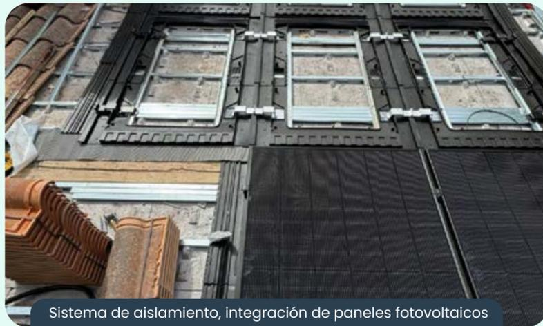
Sistema de aislamiento, integración de paneles fotovoltaicos
