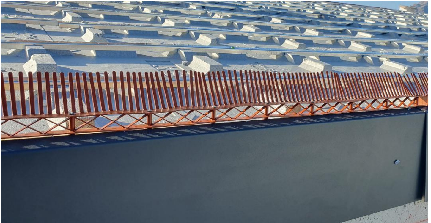
Rastrel + Peine Alero rojo Panel SAT y Rastrel metálico U 40 x 15
