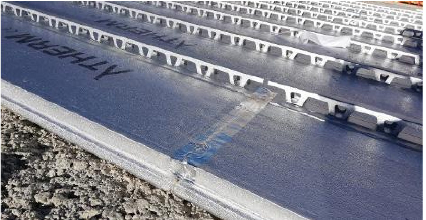
Panneau THERM Ruban de butyle 100 mm
