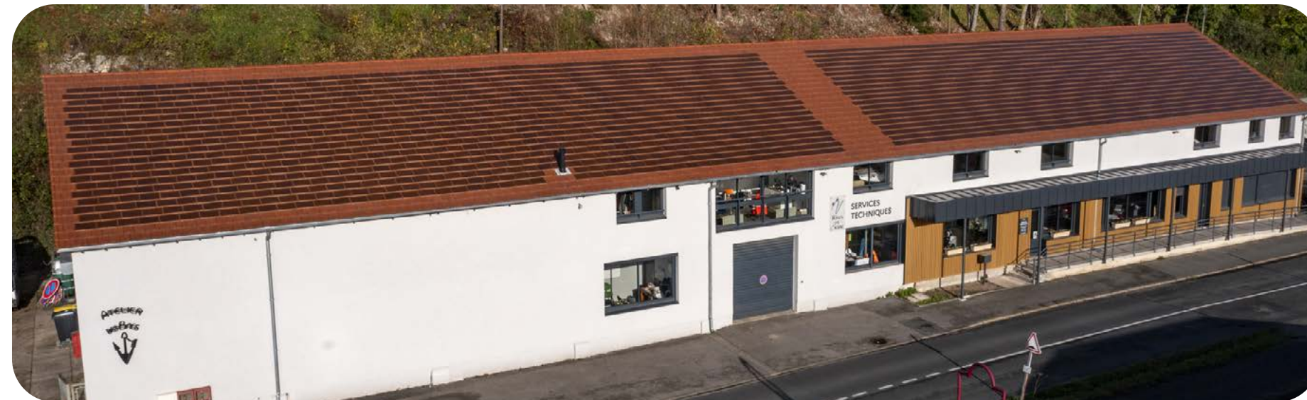
> Vista panorámica del edificio de Servicios Técnicos
