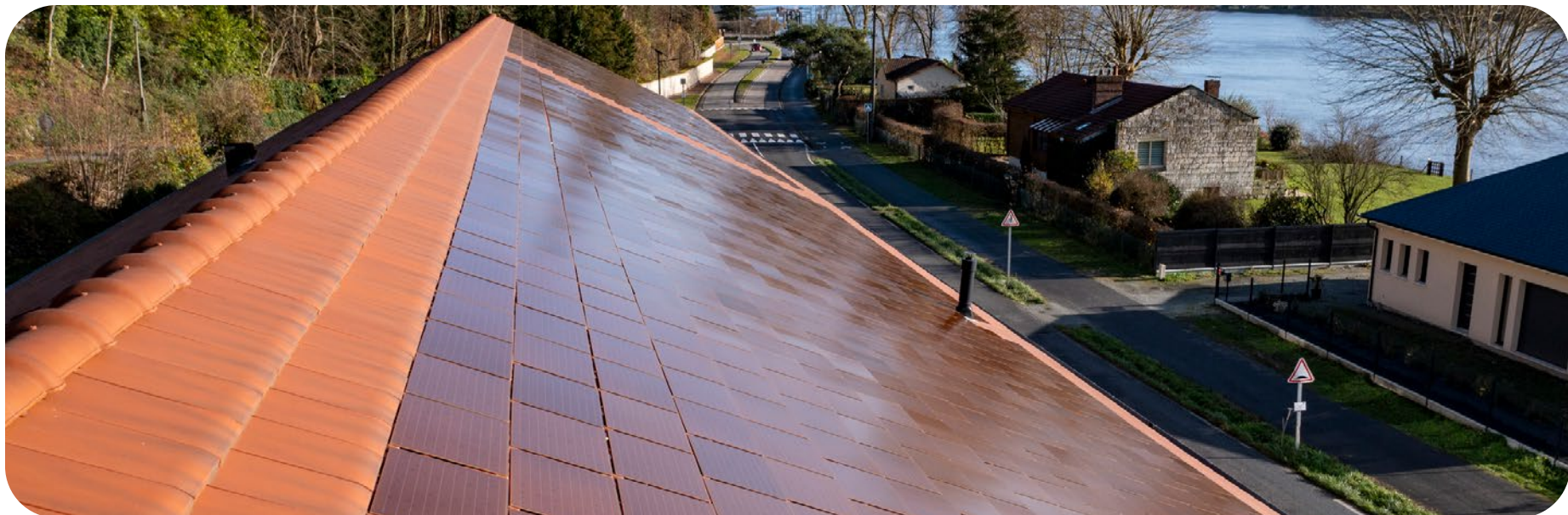
> Versant de la toiture orienté plein Sud
